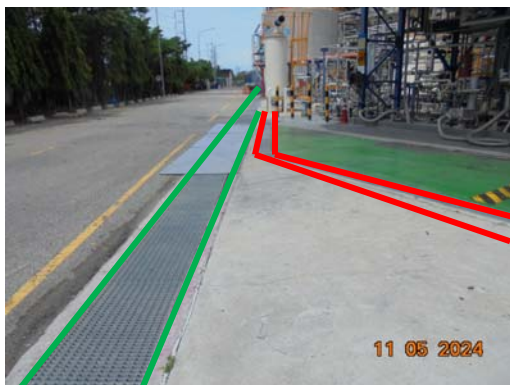
รูปที่ 3.24 ระบบรวบรวมน้ำเสียแยกจากระบบ ระบายน้ำฝนอย่างชัดเจน
