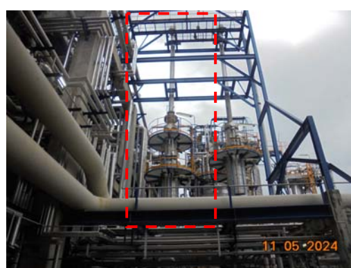
รูปที่ 3.3 ระบบ Acetone Scrubber (D-1904)
