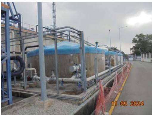
รูปที่ 3.22 ระบบบำบัดน้ำเสียชีวภาพ
