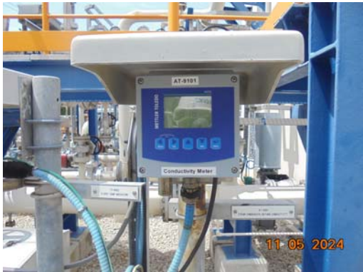
รูปที่ 3.20 ระบบตรวจวัดค่า Conductivity แบบอัตโนมัติ
