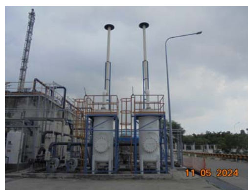
รูปที่ 3.5 ปล่องระบบดูดซับไอระเหย สารอินทรีย์ด้วยถ่านกัมมันต์จากระบบบำบัดน้ำเสีย (D-9201 และ D-9202)
