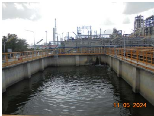
รูปที่ 3.17 บ่อพักน้ำทิ้ง (Final Polishing Tank)
