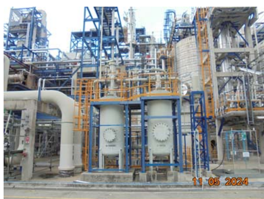
รูปที่ 3.4 ปล่องระบบดูดซับไอระเหยสารอินทรีย์ ด้วยถ่านกัมมันต์จากระบวนการผลิต (D-1905A และ D-1905B)
