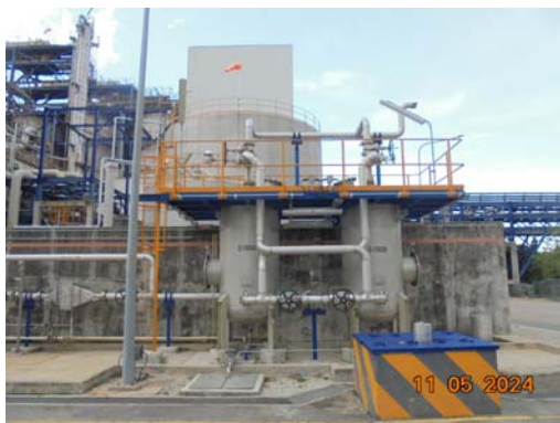
รูปที่ 3.6 ปล่องระบบดูดซับไอระเหยสารอินทรีย์ด้วยถ่านกัมมันต์ จากถัง TK-1922 TK-1923 (D-1906)
